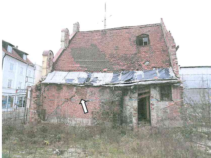
(02) Ansicht von Westen nach dem Abbruch des südlichen Anbaus und der Nachbarhäuser. Links ist das nicht verputzte bauzeitliche Mauerwerk (vor 1665 (d)) zu sehen, unterhalb der Traufe ist eine um 1900 zugesetzte Öffnung zu erkennen (Pfeil).
