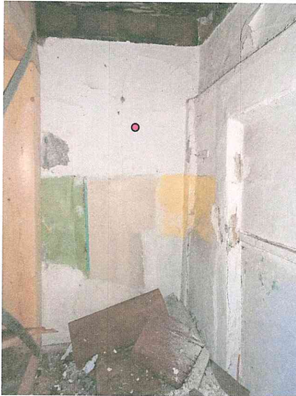
(35) 1. Dachgeschoss, Raum 1.03 nach Süden: rechts im Bild die Fachwerkwand zum Fletz (1866 (d)), die Südwand aus Heraklit zum Raum 1.04 wurde in der ersten Hälfte des 20. Jahrhunderts eingebaut (violetter Punkt)
