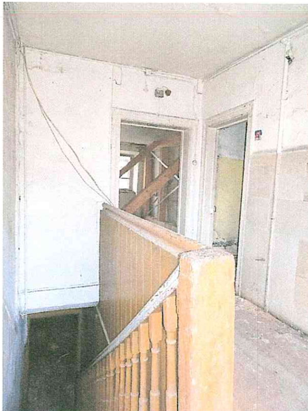
(28) 1. Dachgeschoss, Raum 1.01 nach Norden: Diele des Dachgeschossausbaus von 1866 (d unter Vorbehalt). Das Treppengeländer mit gedrehten Traljen und die profilierten Zargen der Türen stammen aus der gleichen Bauphase.
