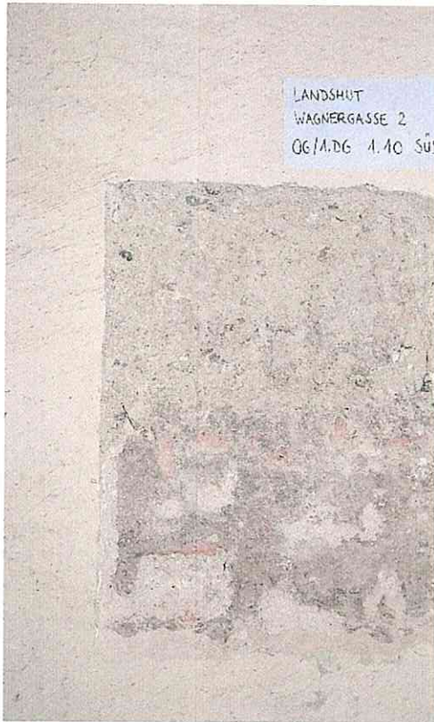
(39) 1. Dachgeschoss, Raum 1.10, S Teilstück des im 1. Dachgeschoss e gebliebenen bauzeitlichen Südgieb verstrichenem grauem Setzmörtel (vor
