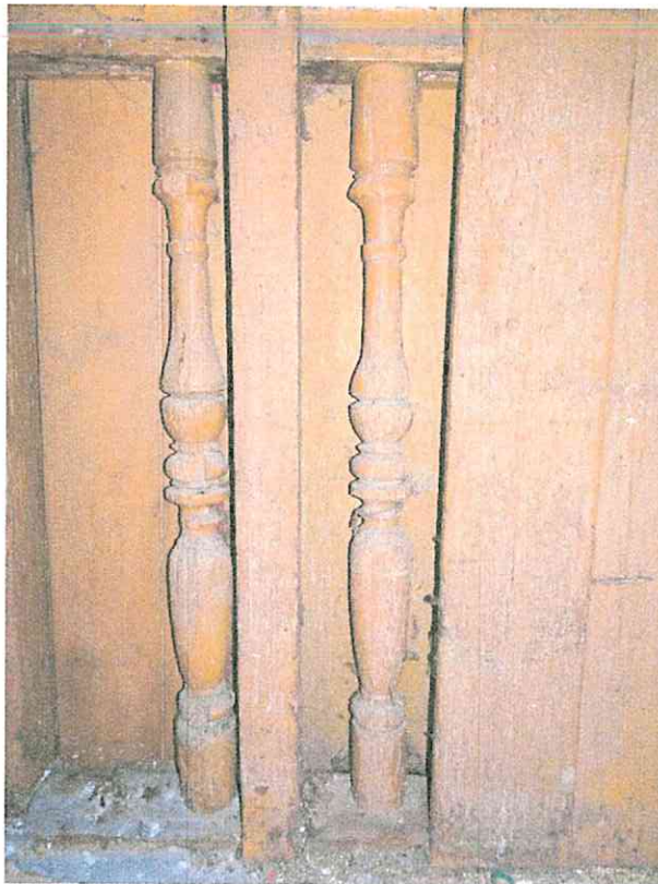
(30) 1. Dachgeschoss, Raum 1.01, Detail Treppengeländer: zwei zweitverwendete gedrechselte Stäbe, möglicherweise aus dem 18. Jahrhundert.
