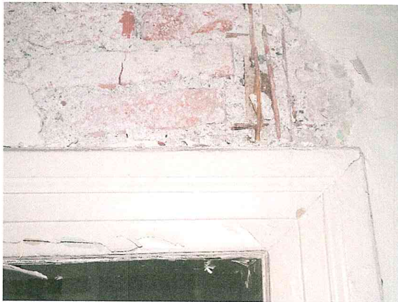
(34) 1. Dachgeschoss, Raum 1.02, Westwand: Detail der Tür zum Raum 1.11 mit der profilierten Zarge von 1866 (d). Neben der Ziegelausfachung sind wieder die mit geschmiedeten Nägeln auf dem Stock befestigten Rohrmatten zu sehen.
