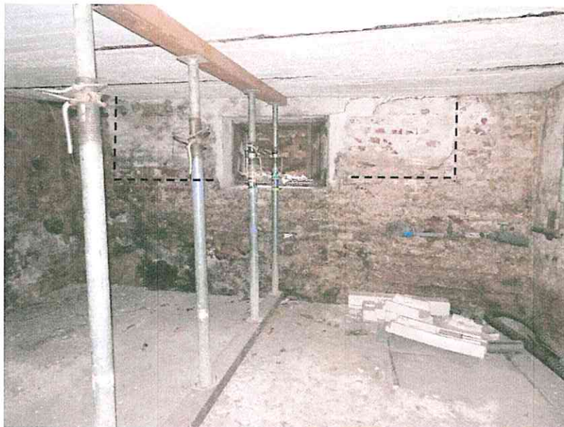
(08) Keller, Raum -1.02 nach Norden: der bauzeitliche Keller besaß ursprünglich ein Tonnengewölbe mit zwei auf zwei Jochen und einer Mittelstütze. Dieses wurde 1934 (a) abgebrochen und durch eine ausbetonierte Schienendecke ersetzt. In der Nordwand sind zwei wohl erst um 1900 mit Vollziegeln zugesetzte Fenster zu erkennen.
