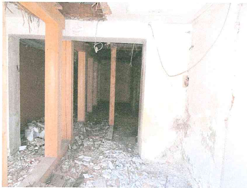
(21) Erdgeschoss, Raum 0.03 nach Norden: bauzeitliche Wand zum Raum 0.02 mit nachträglich vergrößerter Öffnung. Die Putzdecke mit Rohrmatten als Putzträger und Haken als Befestigung stammt aus der ersten Hälfte des 20. Jahrhunderts.
