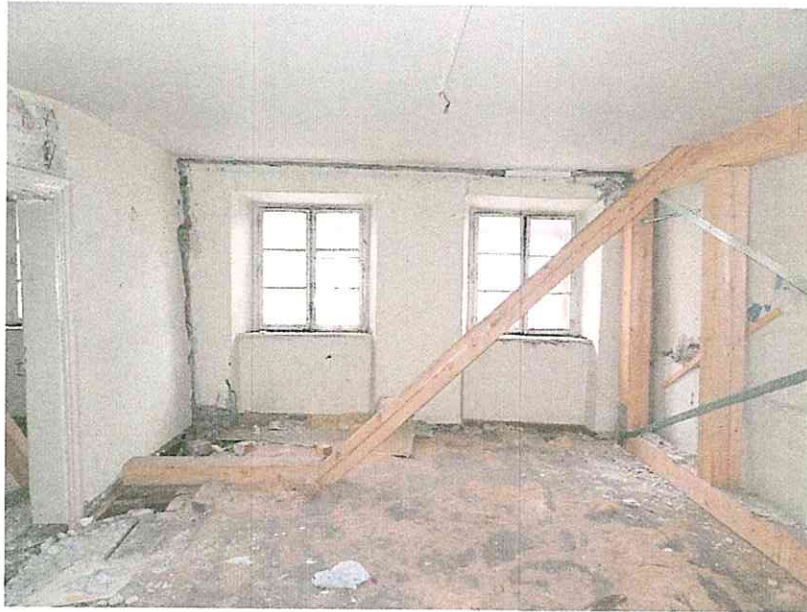
(31) 1. Dachgeschoss, Raum 1.02 nach Norden: beim Dachgeschossausbau von 1866 (d unter Vorbehalt), zu dem die beiden Wände links und rechts im Bild gehören, wurde vor den Nordgiebel eine Vorsatzschale aus Ziegeln errichtet und die Fensteröffnungen in den Giebel gebrochen. Die Fensterstöcke mit zwei Flügeln gehören noch in diese Bauphase.
