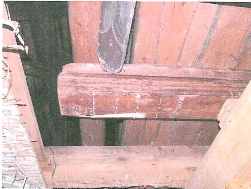
(25) Erdgeschoss, Raum 0.12, Decke: profilierter Decken- bzw. Zerrbalken mit Nut für eine Bretter-Leisten-Decke wie in Raum 0.02 (1665 (d)). Die beigelegten gesägten Balken und die Putzdecke mit Rohrmatten und Häkchen stammen von 1934 (a). Die Zerrbalken wurden aufgrund von Schäden schon damals abgesägt.
