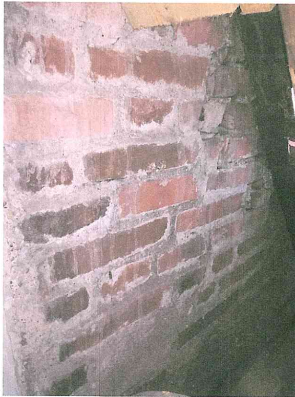
(44) 2. Dachgeschoss, Innenseite Nordgiebel: Mauerwerk in der östlichen Abseite (vor 1665 (d)).
