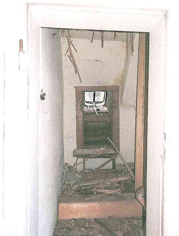
(36) 1. Dachgeschoss, Raum 1.04 nach Osten: durch die Abtrennung vom Raum 1.03 in der ersten Hälfte des 20. Jahrhunderts entstandene Toilette mit Dachfenster und Türzarge aus der gleichen Bauphase.
