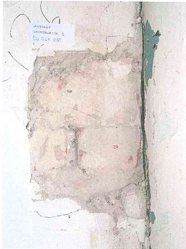
(13) Erdgeschoss, Raum 0.01, Südostecke Fletz: bauzeitliches Mauerwerk mit verstrichenem Fugenmörtel und Kalkschlämme (vor 1665 (d), vermutlich spätmittelalterlich), mit der Südfassade im Verbund.
