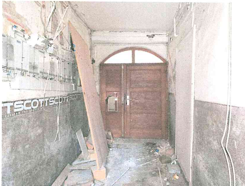
(10) Erdgeschoss, Raum 0.01, Fletz nach Norden: die Wand Links ist bauzeitlich (vor 1665 (d)), die rechte mit der Tür zum Raum 0.02 entstand erst in der Bauphase von 1665 (d). Die Türöffnung zur Wagnergasse dürfte auch bereits 1665 entstanden sein, die heute vorhandene Tür ist modern.
