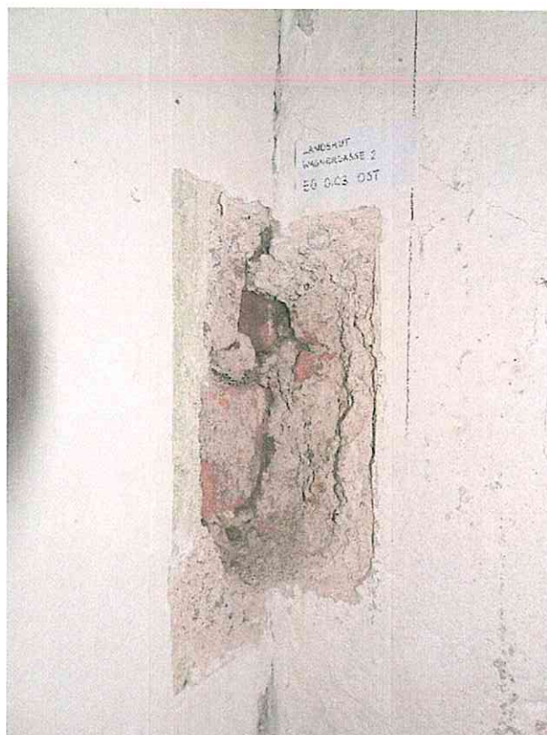
(22) Erdgeschoss, Raum 0.03, Nordostecke: Anschluss der Wand zum Raum 0.02 an die östliche Außenwand. Die Ziegel sind im Verbund gemauert, beide Wände sind bauzeitlich (vor 1665 (d), fester grauer Setzmörtel mit Kalkspätzen). Der Putz auf den Ziegeln stammt aus der ersten Hälfte des 20. Jahrhunderts, ältere Putze wurden abgeschlagen.
