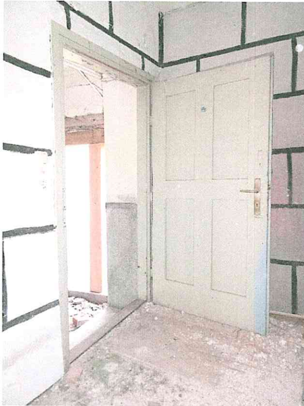
(27) Erdgeschoss, Raum 0.12, Südostecke: in der bauzeitlichen Wand befindet sich ein Türrdurchbruch von 1934 (a) mit Zarge und Türblatt aus dieser Zeit.
