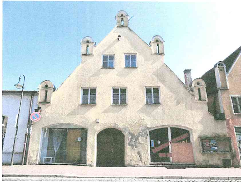
(01) Ansicht von Norden: das bereits 1549 erstmals erwähnte Bäckeranwesen bekam 1665 ein neues Dachwerk. Die Fenster der Dachgeschosse entstanden zusammen mit dem Ausbau zu Wohnzwecken 1866 (d unter Vorbehalt). Die beiden Schau- fensteröffnungen im Erdgeschoss wurden 1934 (a) in die heutige Form gebracht, die Fenster selbst sind, wie auch die Tür, jünger.
