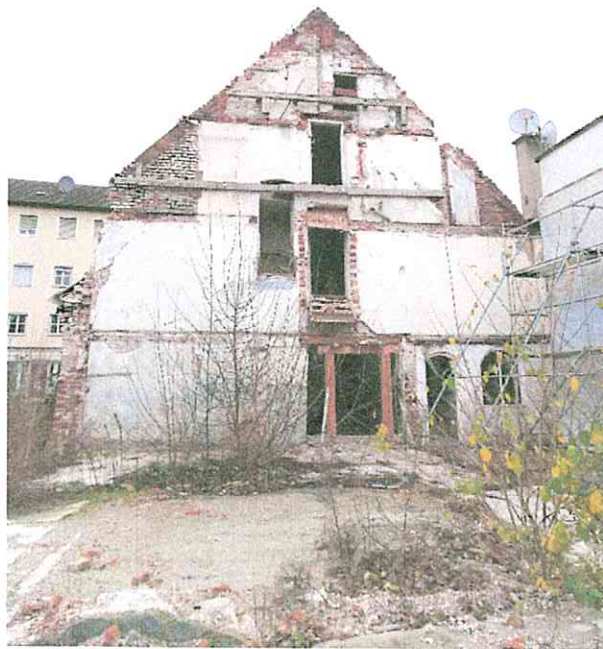
(04) Ansicht von Süden: hier sind die nachträglichen Aufbrüche zur Anbindung des inzwischen abgebrochenen südlichen Anbaus zu sehen. Der Anbau bestand 1810 bereits (a), ein Vergleich der Setzmörtel legt nahe, dass er schon 1665 (d) entstanden war.
