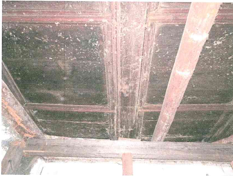
(17) Erdgeschoss, Raum 0.02: Detail der schwarz lasierten Bretter-Leisten-Decke mit den profilierten Zerrbalken von 1665 (d).
