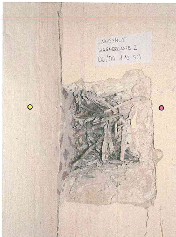
(38) 1. Dachgeschoss, Raum 1.10, Südostecke: die in den Raum einspringende Ecke entstand erst in der ersten Hälfte des 20. Jahrhunderts. Hier ist der Anschluss der jüngeren Wand aus Heraklit (rechts, violetter Punkt) an den Dachausbau von 1866 (d unter Vorbehalt, gelber Punkt) zu sehen.
