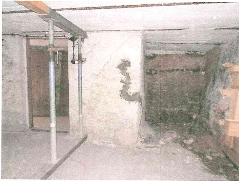
(09) Keller, Raum -1.02 nach Süden: 1934 (a) wurde ein Vorraum vom bauzeitlichen Keller (vor 1665 (d)) abgeteilt (links). Aus der gleichen Zeit stammt die Schienendecke.
