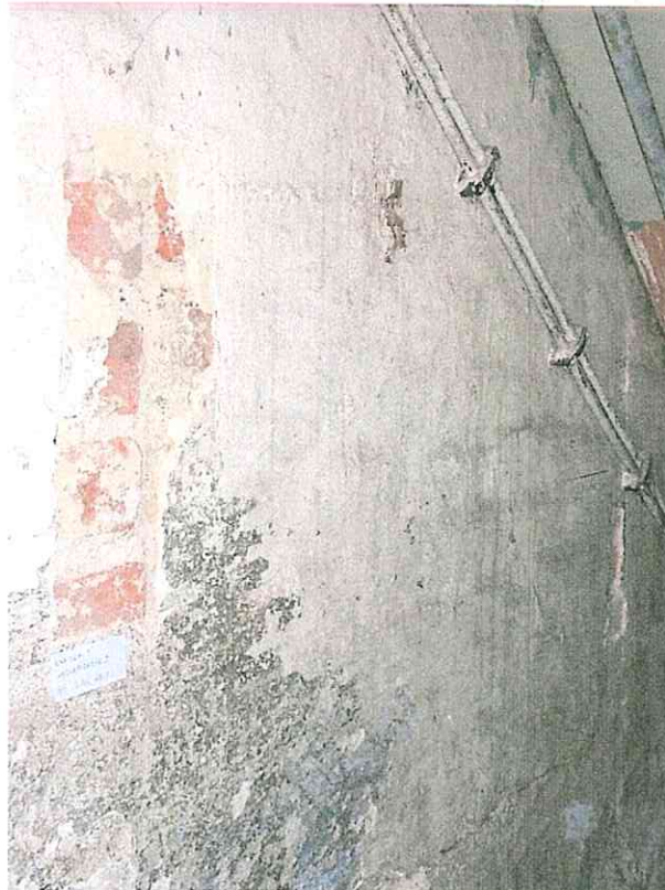
(14) Erdgeschoss, Raum 0.01, Westwand Fletz: im bauzeitlichen Mauerwerk (vor 1665 (d)) ist eine Öffnung zum Raum 0.12 zu sehen, die noch vor der Bauphase von 1665 zugesetzt worden ist. Die Ziegel der Zusetzung weisen noch verstrichenen Fugenmörtel und eine Kalkschlämme als Oberfläche auf.
