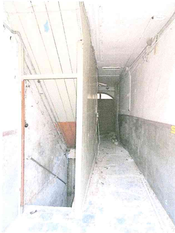
(11) Erdgeschoss, Raum 0.01, Fletz nach Norden: der Treppenlauf in den Keller wurde nachträglich in den Fletz verlegt. Da er auf dem Eingabeplan von 1934 schon als Bestand eingetragen ist, muss er älter sein. Die Einhausung der Treppenläufe entstand in der ersten Hälfte des 20. Jahrhunderts.
