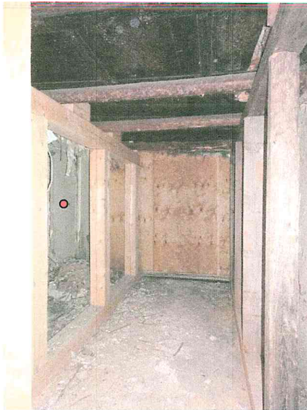
(16) Erdgeschoss, Raum 0.02 nach Norden: dieser Raum entstand durch den Einbau der Wand zum Fletz 1665 (d, roter Punkt). Aus dieser Zeit stammt auch die Decke mit den unterseitig profilierten Zerrbalken und den schwarz lasierten Feldern mit Brettern und Leisten.
