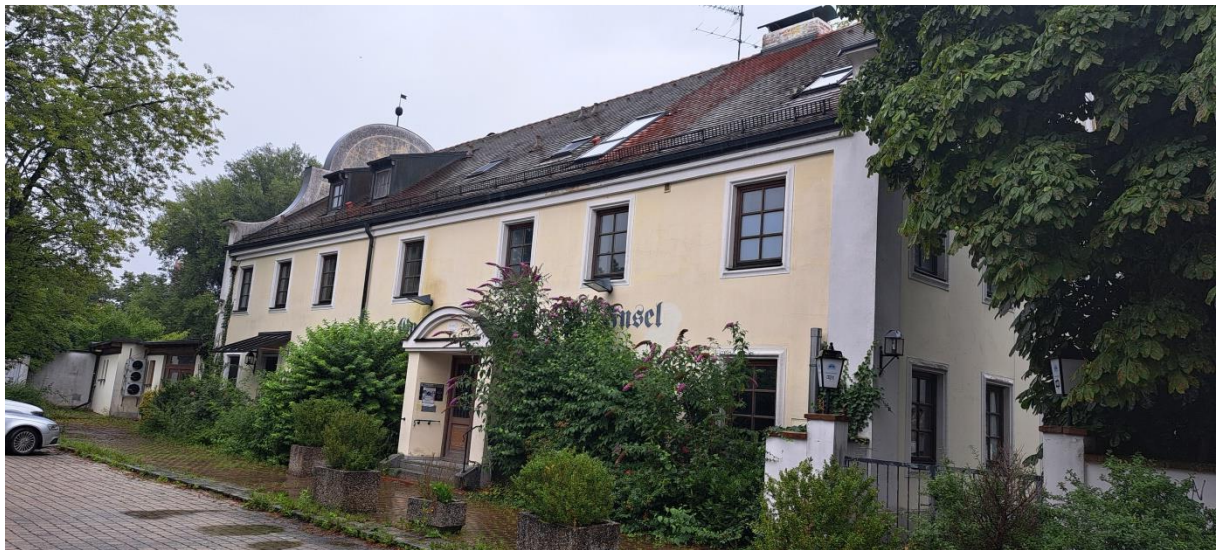
Abb. 5 Nordwestfassade des Gebäudes mit Dachgauben
