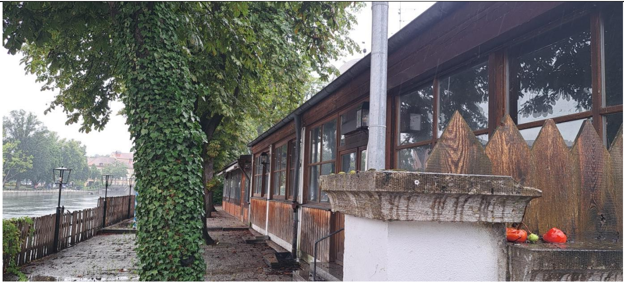
Abb. 6 Zur Isar hin ausgerichtete Südostfassade des Wintergartens mit möglichen Quartieren in der Holzverkleidung unterhalb der Dachrinne
