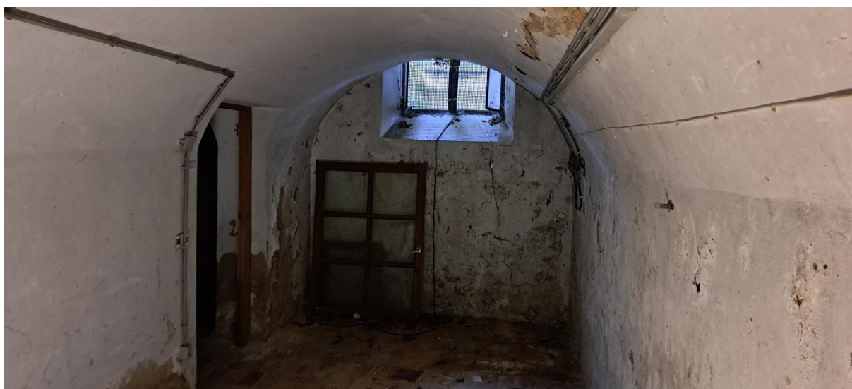
Abb. 3 Kellerraum mit verputzter Gewölbedecke und Kellerfenster mit Gitter
