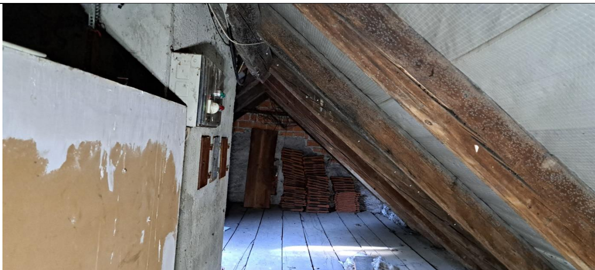
Abb. 2 Dachstuhl mit Dachschalung und Folie
