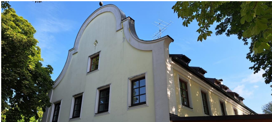
Abb. 7 Südostfassade ohne mögliche Fassadenquartiere aber mit Einflugmöglichkeit in Lüftungslöcher oberhalb des oberen Fensters
