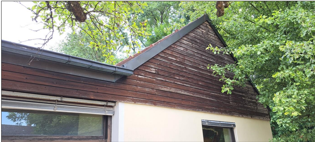
Abb. 5 Südwestseite des Kindergartengebäudes mit Holzfassade und Windfangblechen
