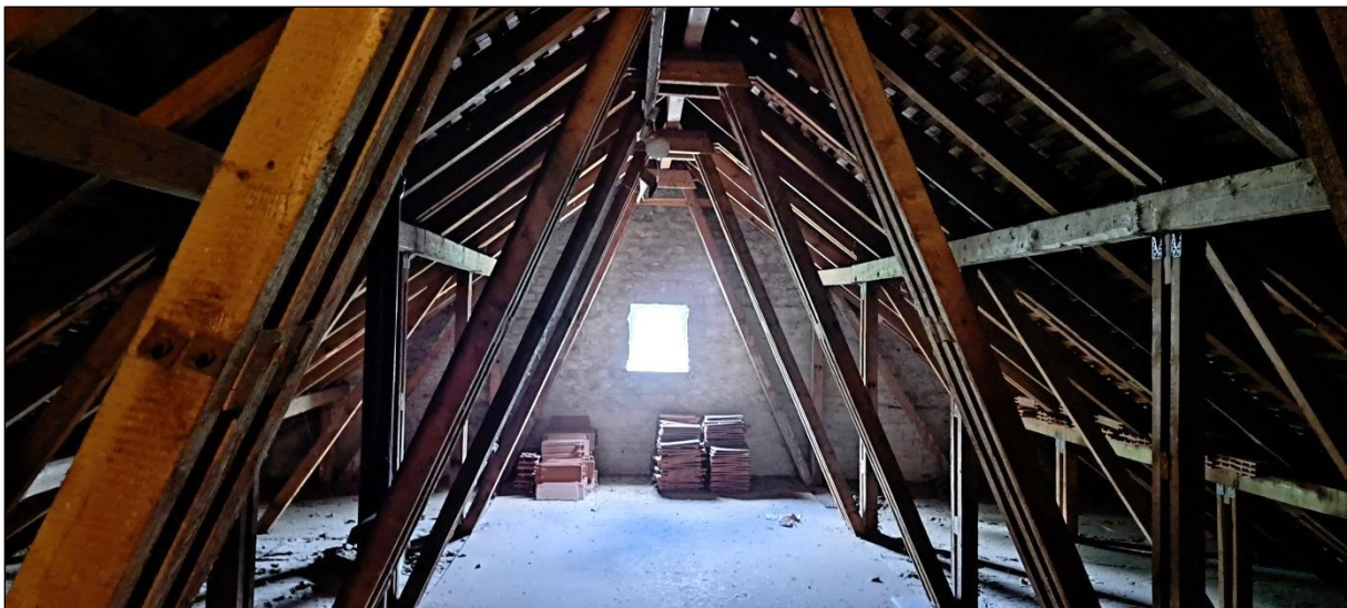
Abb. 2 Blick in den Dachstuhl des Hauptgebäudes
