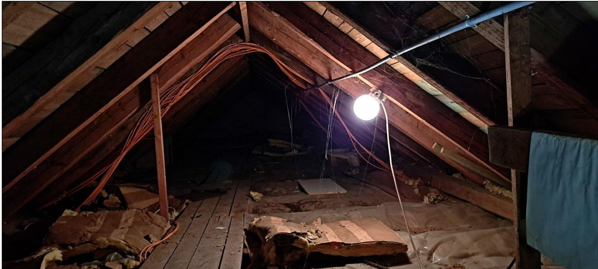
Abb. 4 Dachstuhl über dem Kindergarten
