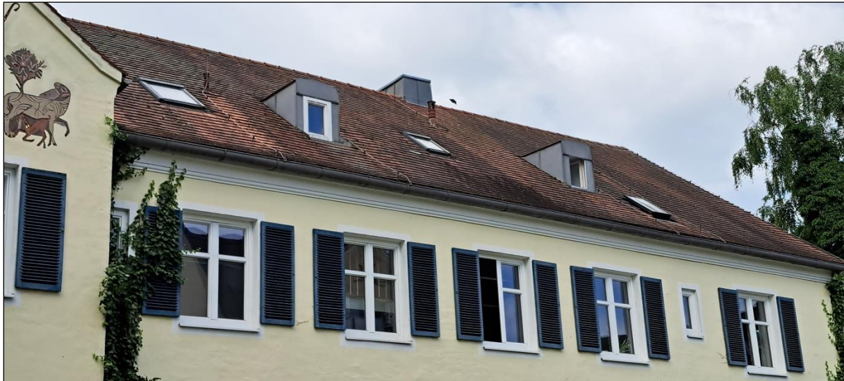
Abb. 3 Fensterläden und Dachsims mit Dachrinne
